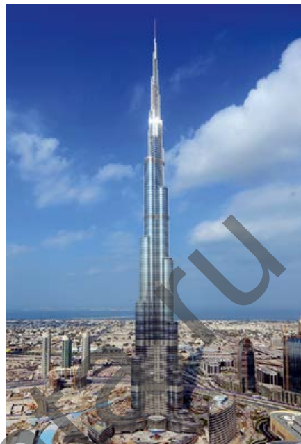
Здание башни Бурдж-Халифа (Дубай)
